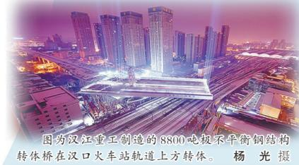
图为汉江重工制造的8800吨极不平衡钢结构转体桥在汉口火车站轨道上方转体。杨光摄
